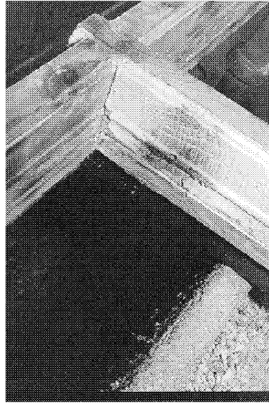
Figur 8.10 Färgborttagning med hetluft.
