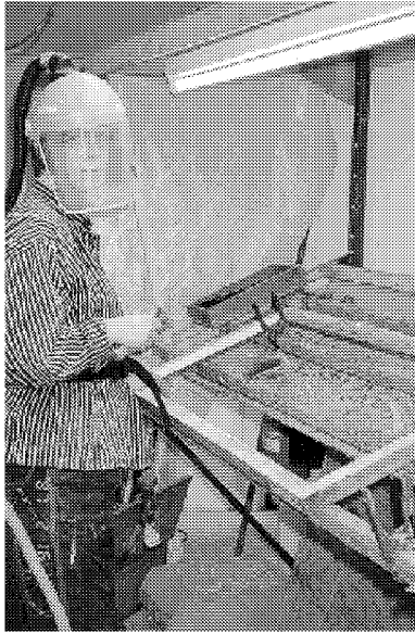
Figur 8.9 Färgborttagning med hetluft.
