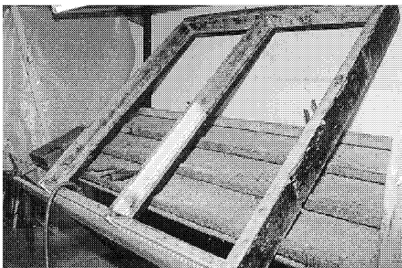
Figur 8.8 Färgborttagning med hetluft.
