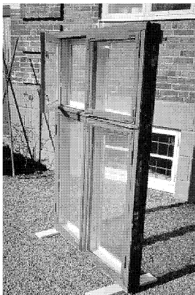
Figur 8.1 Fönster nr 1 är ett 4-lufts-fönster med krysspöst och enkla ytter- och innerbågar. Tillverkningsår ca 1880.
