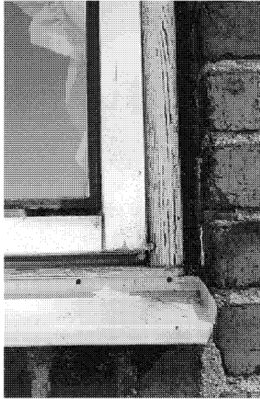
Figur 8.21 Detalj av fönster nr 3 som visar på ett hårt slitage av ytbehandlingen.
